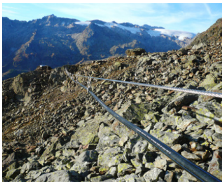
Kabel der Seilbrücke und Aufhängung der Wasserleitung
