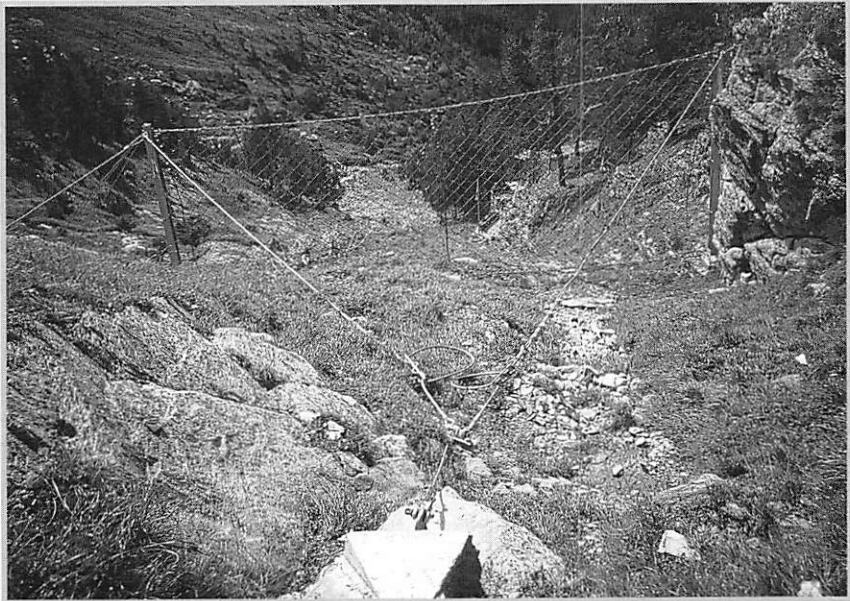
Das im August 2001 erstellte Steinschlagnetz befindet sich rund 60 Meter oberhalb der Engelhornhütte. Es schützt den letzten Wegabschnitt vor der Hütte sowie den Hüttenvorplatz.
