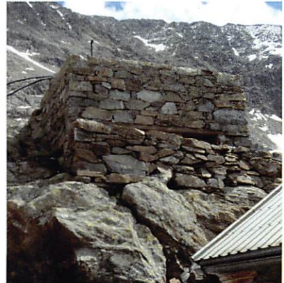
und die fertig eingemauerten Wassertänke
