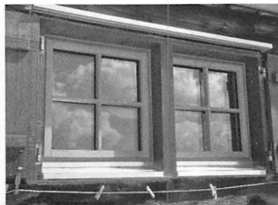
Die neuen Fenster in der Bietschhornhütte
