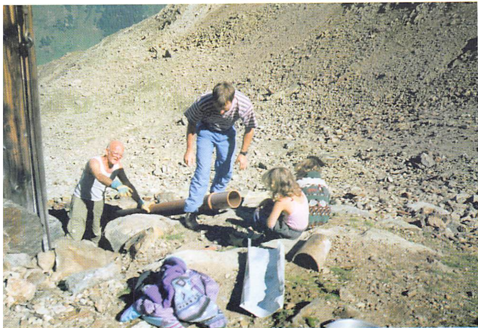
Ein neues Abwasserrohr wird eingebaut
